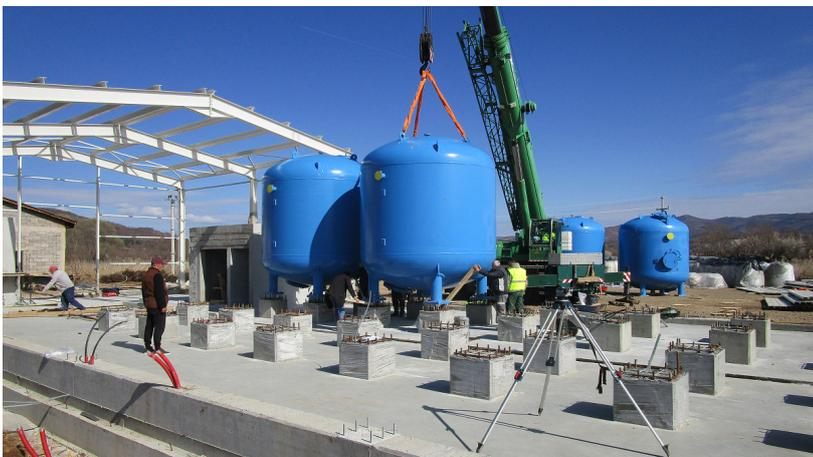
Neue Wasseraufbereitungsanlage (5'200 m<sup>3</sup>/d) in Trabotiviste
