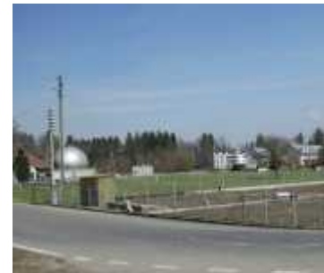
Kugelgasspeicher Thorenberg: kaum bewusste Gefährdung in unmittelbarer Nähe zum Wohngebiet
