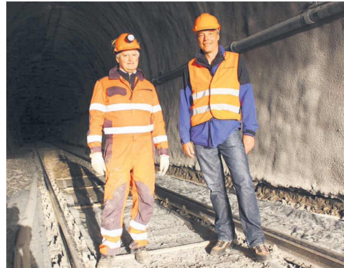
Bauführer Stephan Bendau und Oberbauleiter Günther Fässler (rechts) sind für die Sanierung des Wasserflutunnels verantwortlich.
