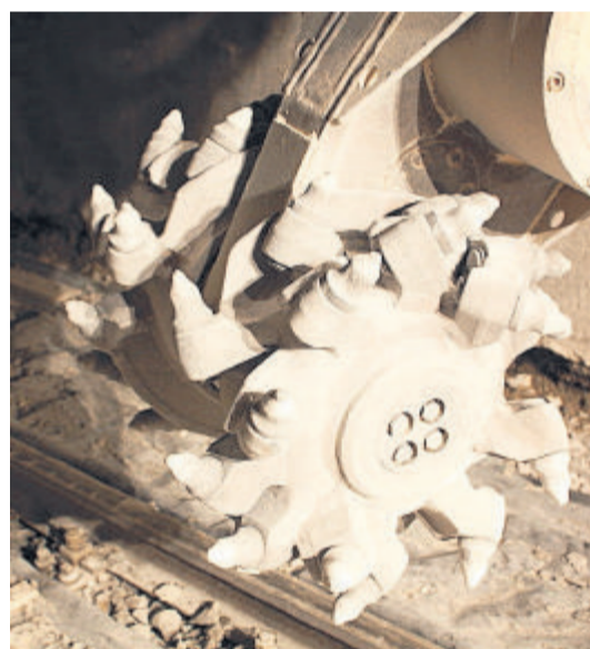
Der Schrämkopf löst den Beton vom Mauerwerk.
