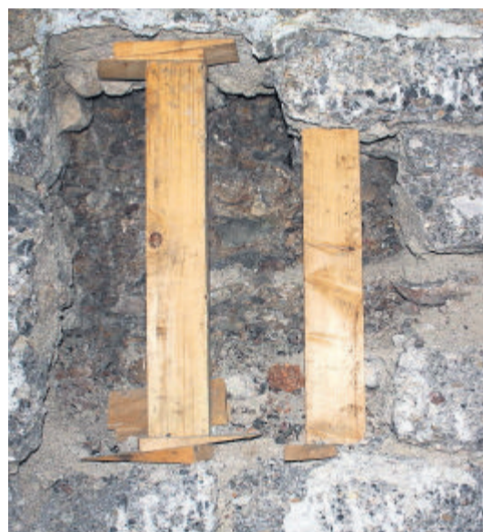
Löcher im Mauerwerk werden neu verfüllt.
