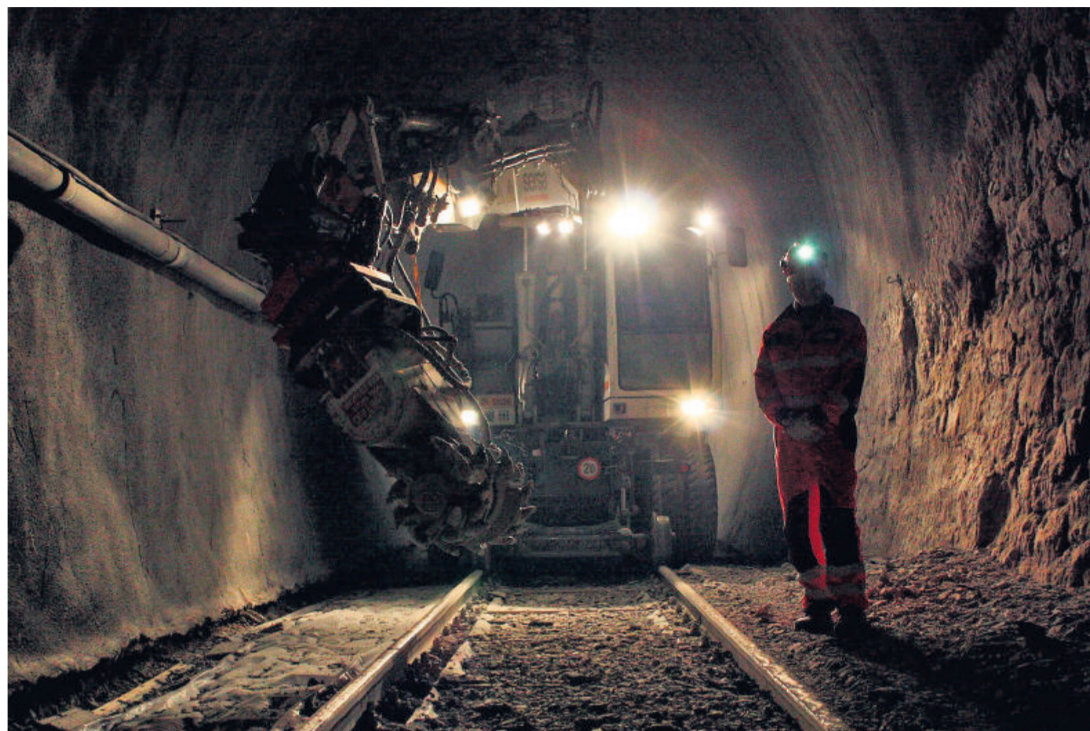
Bauführer Stephan Bendau vor einem Schienenbagger mit Schwenkarm. Mit dem rotierenden Kopf wird die kaputte Betonschale vom Mauerwerk abgelöst.
