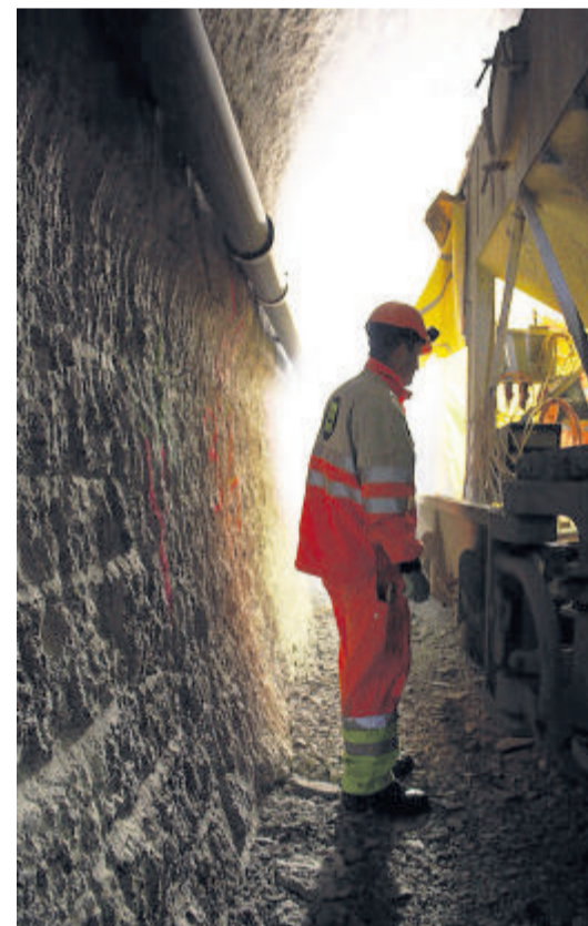
Ein Mineur überwacht die Arbeit.
