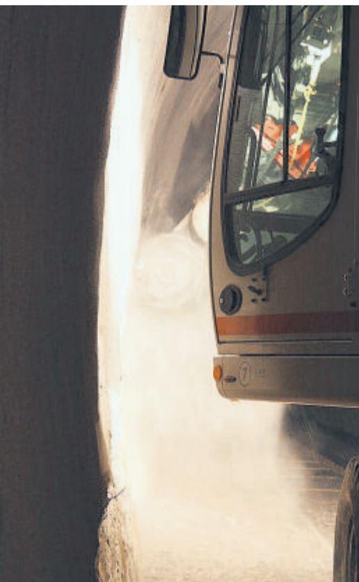
Der alte Beton wird maschinell abgetragen.
