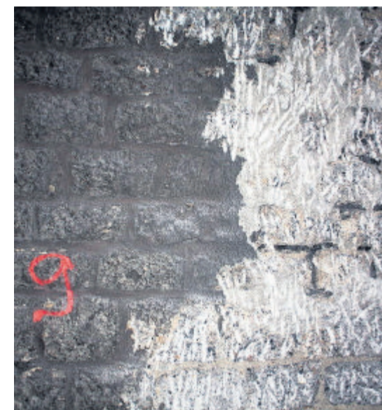
Alte Ablagerungen wurden entfernt.
