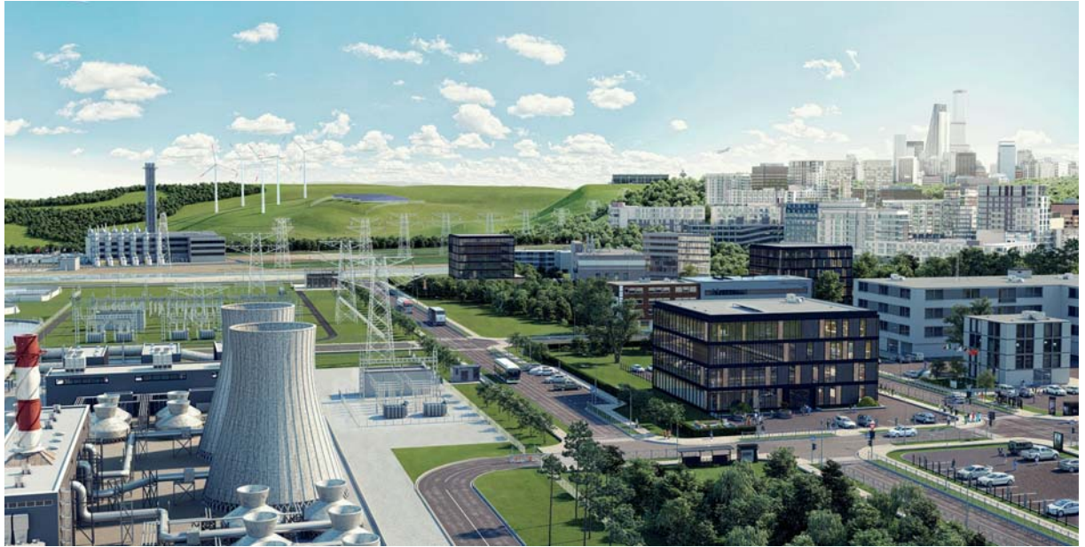
Bild 1: Umspannwerk sowie dezentrale Energieerzeugung durch Windenergie- und Photo- voltaikanlagen- © Phoenix Contact
