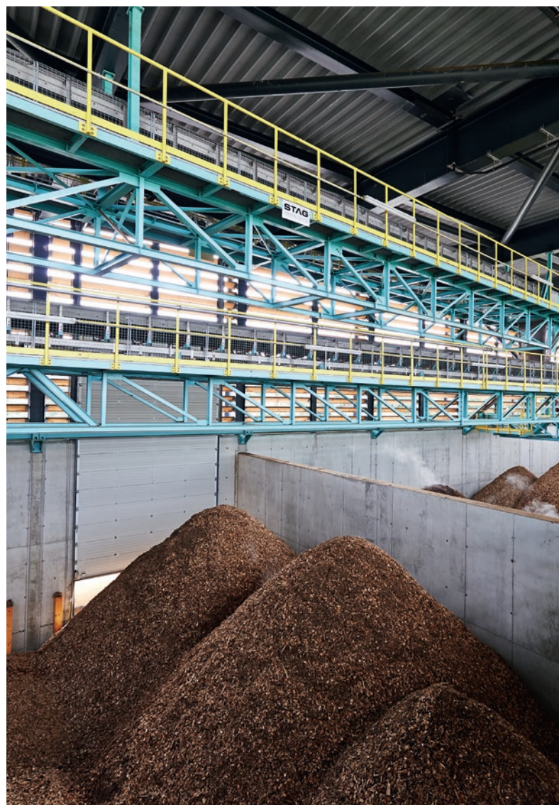
Holz, der Brennstoff für das Holzheizkraftwerk
