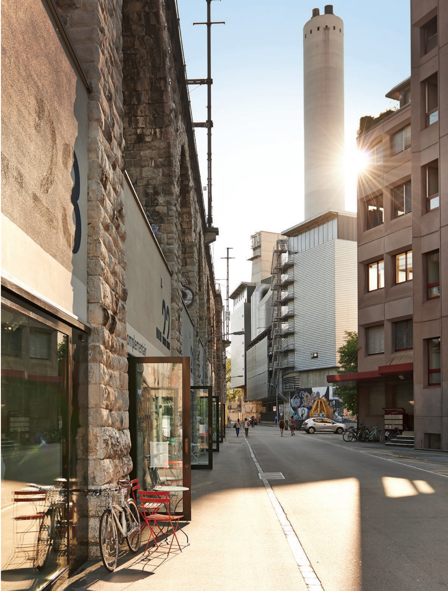
Das Kehrlichtheizkraftwerk Josefstrasse steht heute mitten im aufstrebenden Quartier Zürich-West. Das traditionsreiche Kehrlichtheizkraftwerk soll noch bis ins Jahr 2020 betrieben werden.
