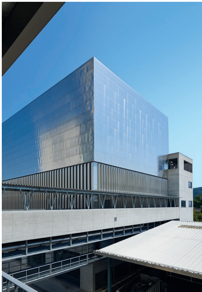
Energiezentrale Kehrriechtheizkraftwerk Hagenholz
